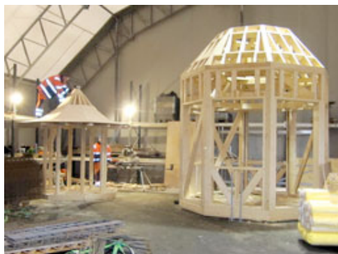
Lysthuset under bygging Januar 2017.
