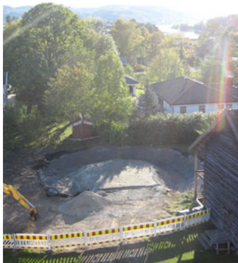
Dammen er gravd ut.
