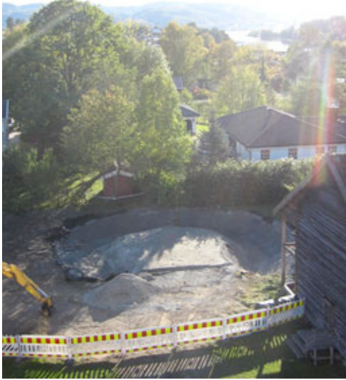
Dammen er gravd ut.
