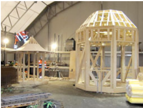
Lysthuset under bygging Januar 2017.
